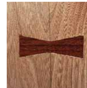
割れ止め、ちぎり
